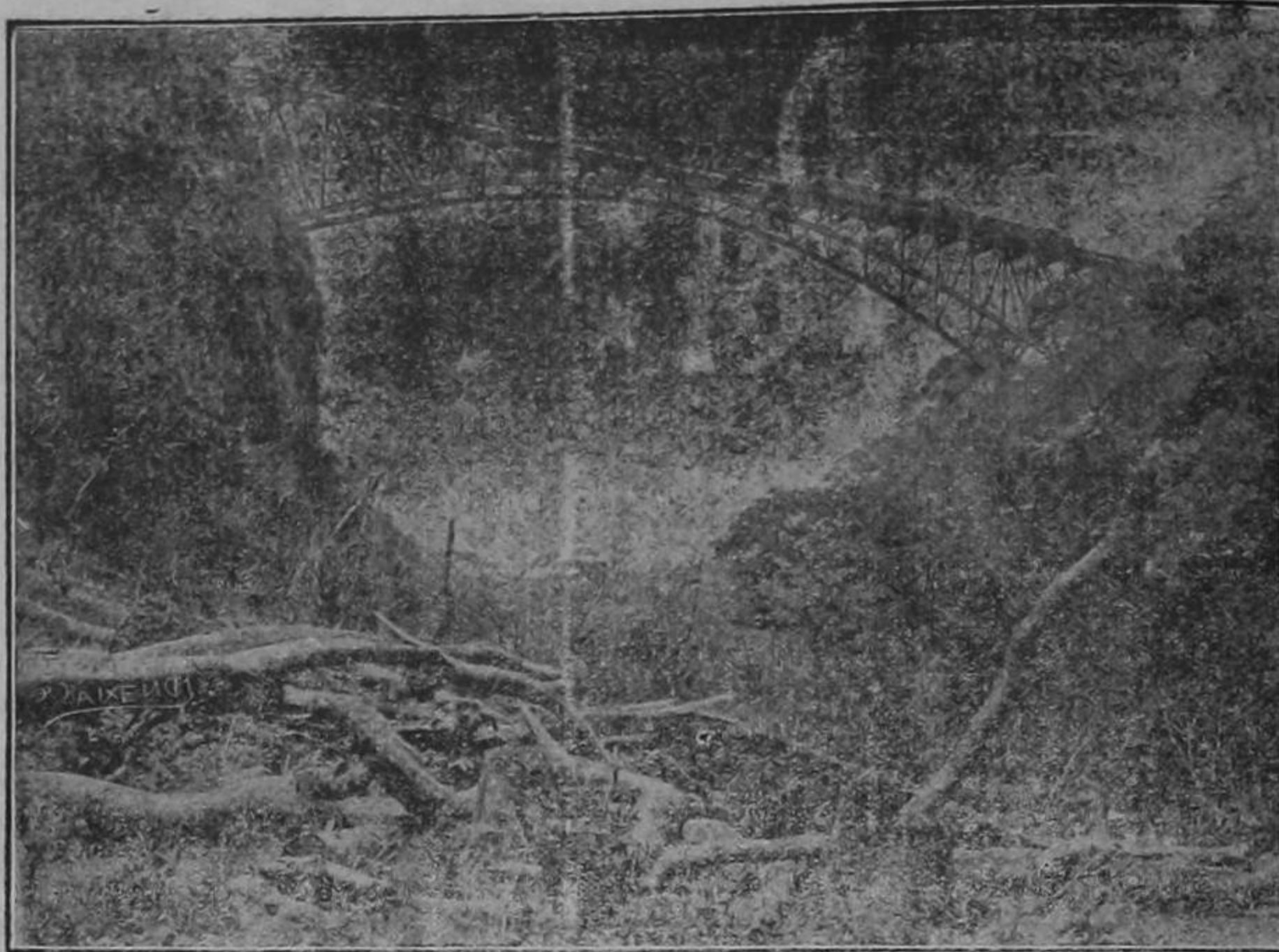
Puente sobre el Río Grande en el Ferrocarril al Pacífico, hermosa obra de ingeniería que mide 228 metros de longitud.
